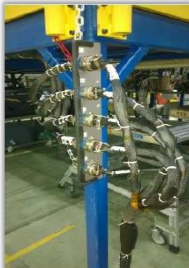
Figura 6-86. Localización de la zona de corte en la plataforma 35.
