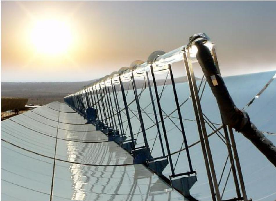
Figura 3-1. Captador cilindro-parabólico (Silva, 2017) [6].
