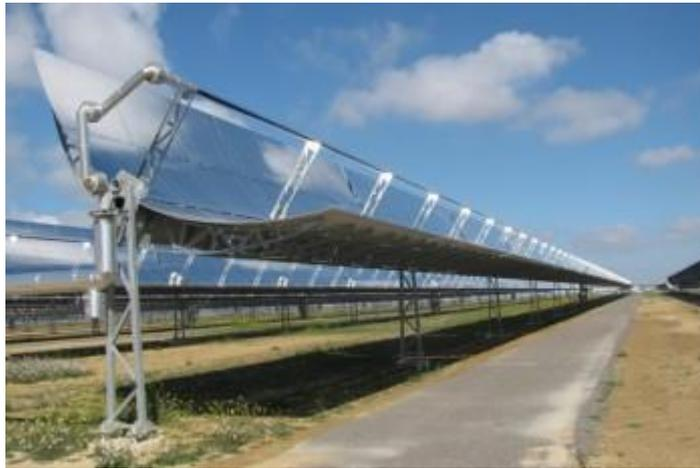
*Figura 1-2. Captador cilindro-parabólico [2].*
