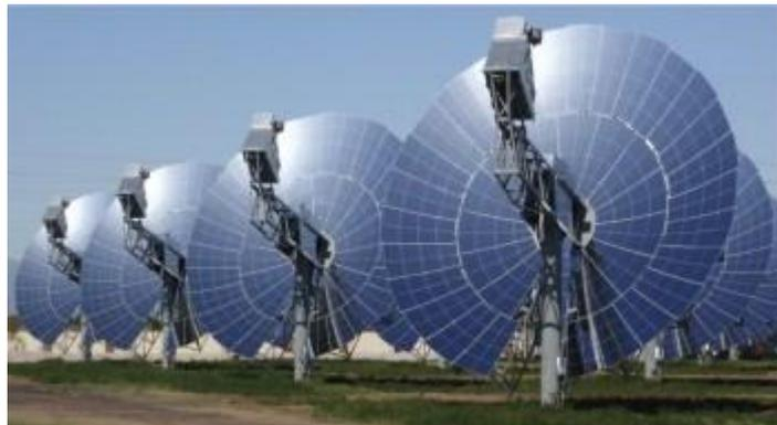
*Figura 1-5. Captador paraboloide [2].*
