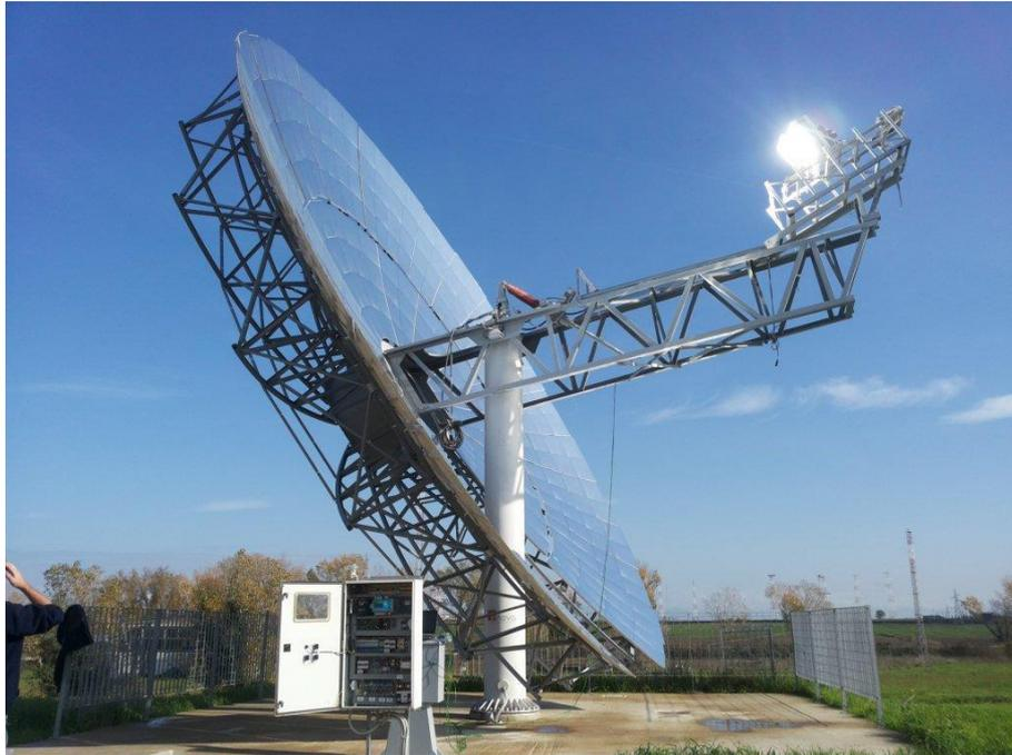
*Figura 2-2. Disco+microturbina de Gas Solar del proyecto OMSoP (Rollán, 2018) [5].*
