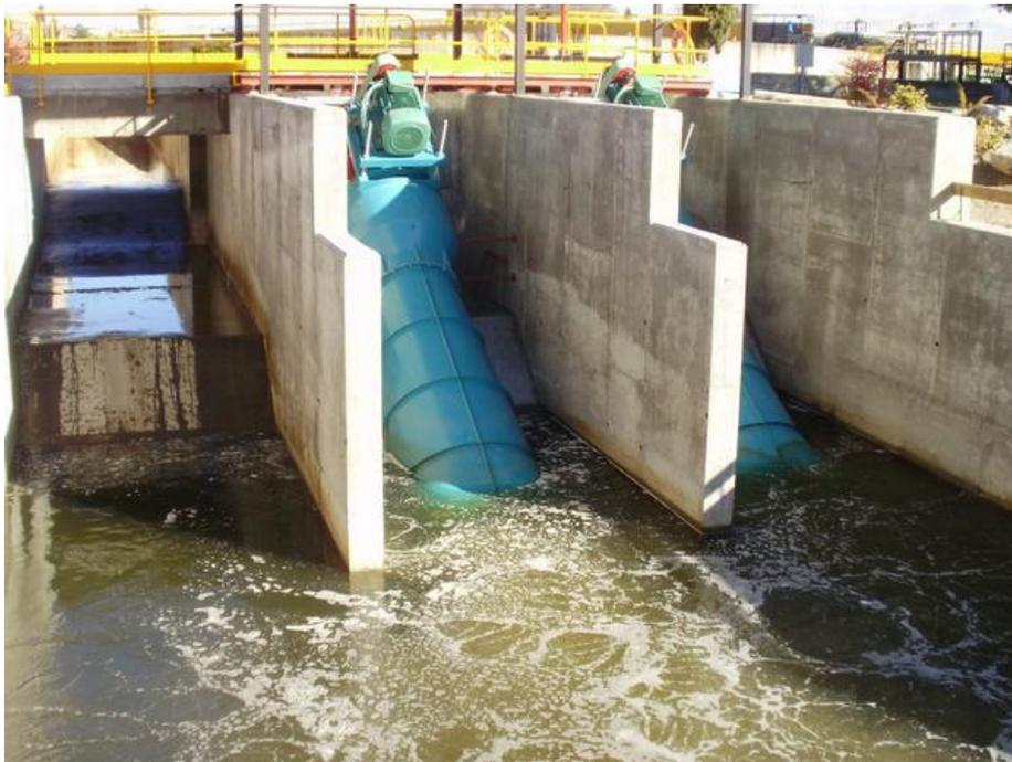
**Figura 13. Turbinas en el desagüe de la EDAR Sur de Madrid, producen 1500 MWh al año. Fuente: (Madrid Subterra, 2017).**
