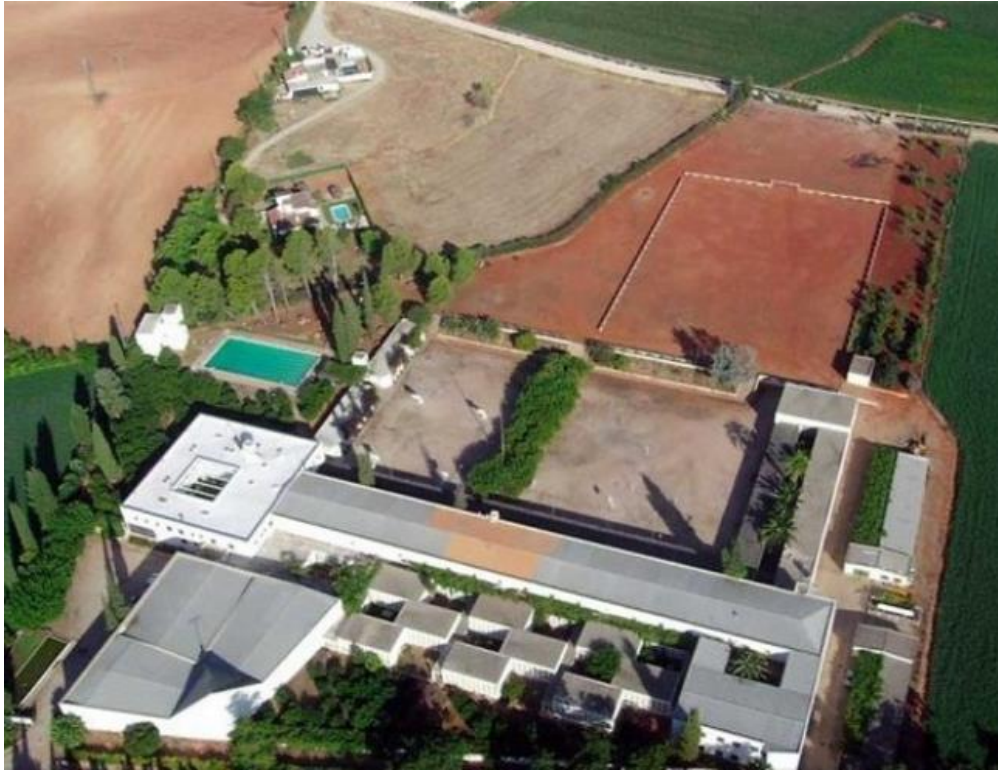
Figura 9: Vista panorámica del edificio.
