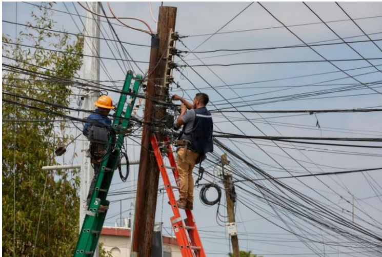
Figura 2 Operarios cambiando la Red de Distribución Eléctrica. Fuente TiempoRegio.Com.
