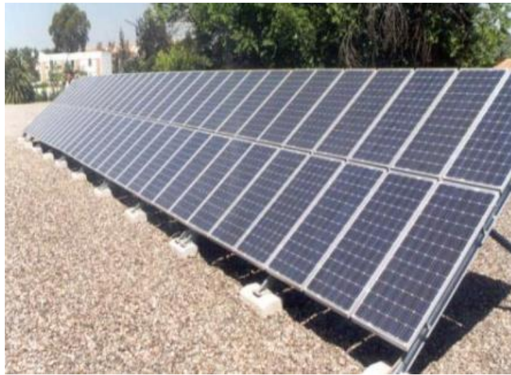
Figura 6. Instalación fotovoltaica aislada [16]
