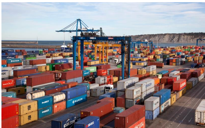
Figura 7: Zona de almacenaje
