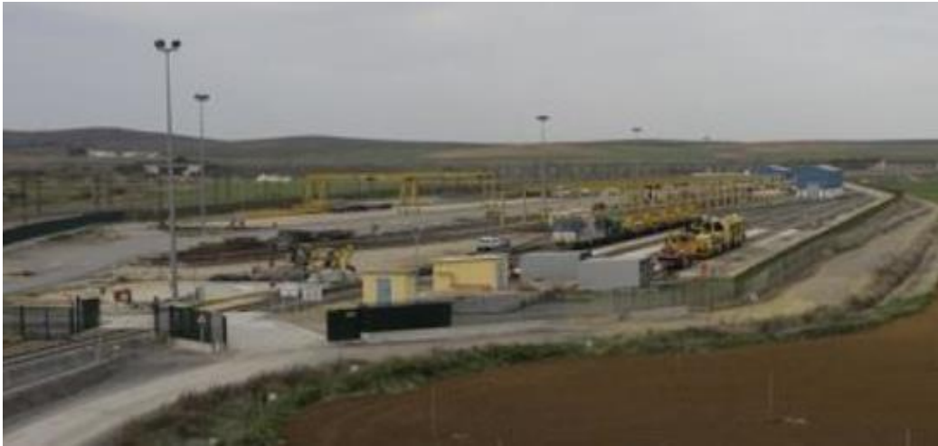
Figura 3: Puerto seco de Antequera
