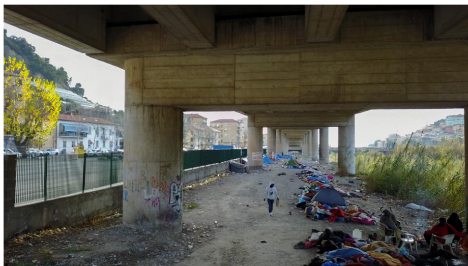
Imagen 3.5. Asentamiento bajo el puente de la Autovía, Via Tenda.
