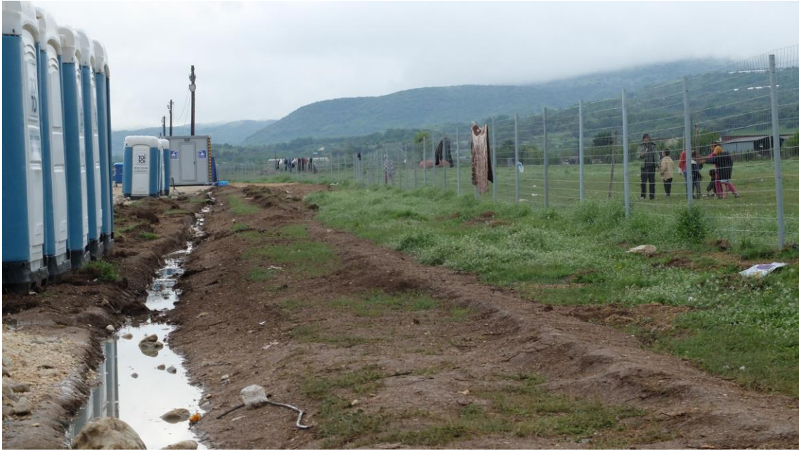
Imagen 4.13. Aguas estancadas conectando baños, duchas y fuentes.
