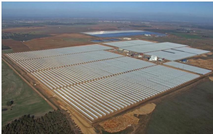
Figura 3-40. Central Solar termoeléctrica La Dehesa (35)
