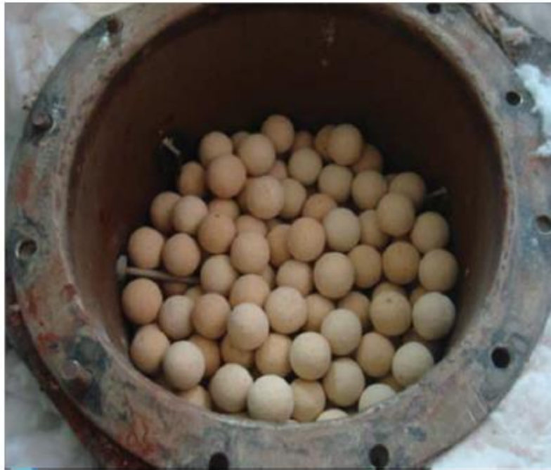
Figura 1-28. Tanque de almacenamiento de lecho compacto. (7)
