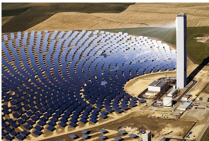
Figura 1-9. Campo de heliostatos. (5)
