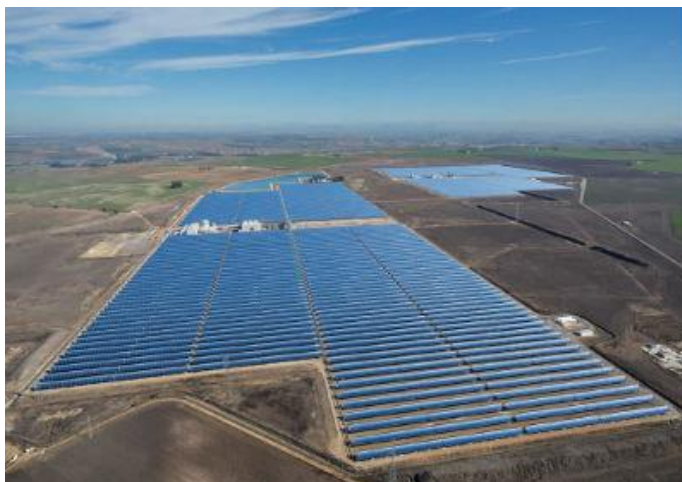
Figura 3-42. Helioenergy I y II. (29)
