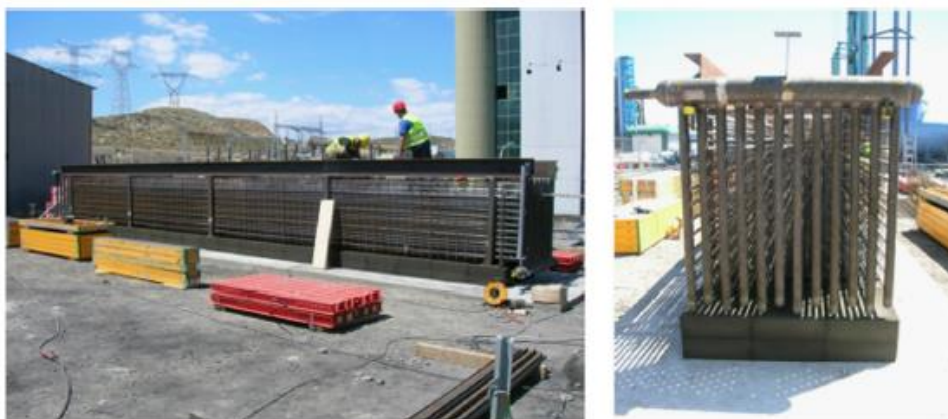
Figura 2-46. Tubos y colectores para tanque rectangular. (22)
