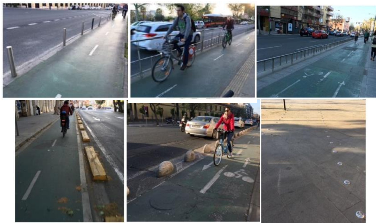
Figura 4-12. Diferentes elementos de separación en la red ciclista de Sevilla. Fuente: Programa de la Bicicleta Sevilla 2020 [18].
