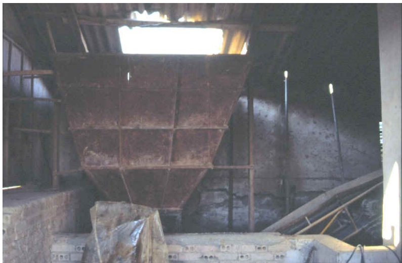
Fig. 27 - Tolva depósito de la cribadora y tamizadora
