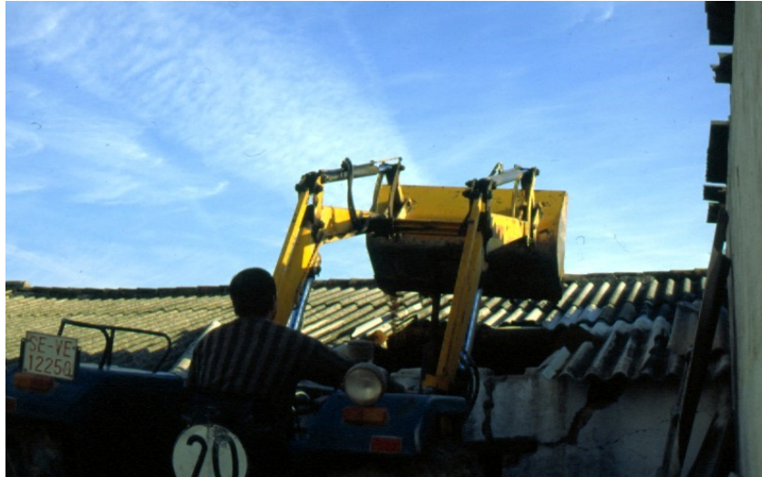
Fig. 26 - Almacén de depósito arcilla
