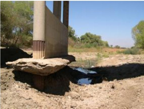
Figura 4: Ejemplo socavación puente II
