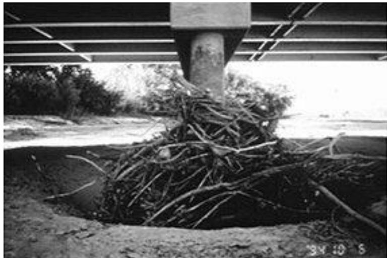
Figura 3: Ejemplo socavación puente I
