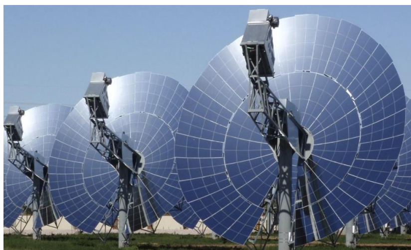
Figura 1-5. Central termosolar de discos parabólicos [5].
