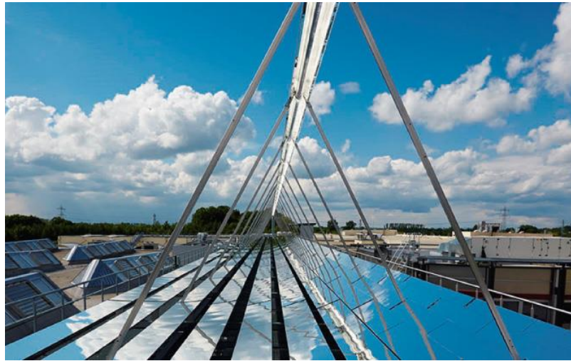
Figura 1-3. Central termosolar de receptores lineales de Fresnel [3].
