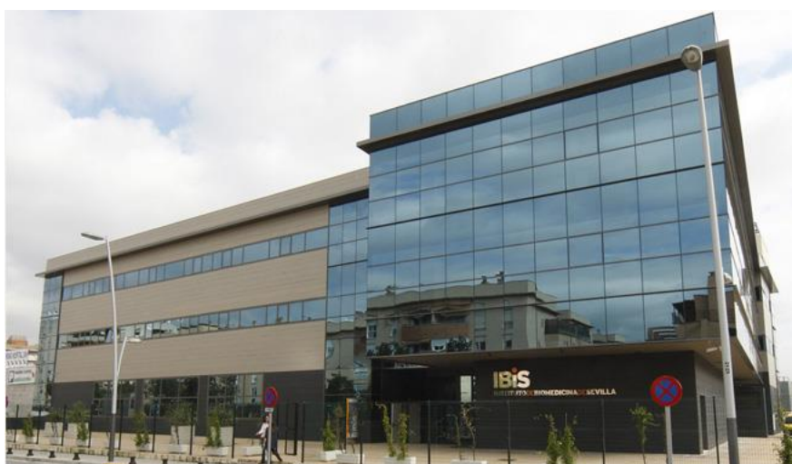
Fig.12 Edificio Instituto Biomedicina de Sevilla
