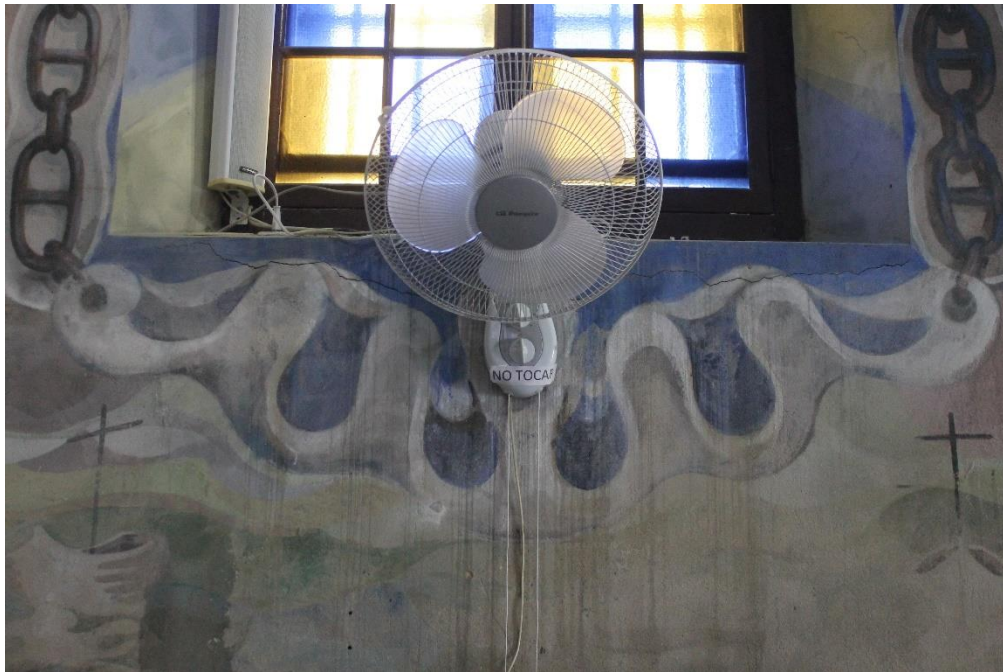
Fotografía 9. Zona inferior de los ventanales. Foto de autor.
