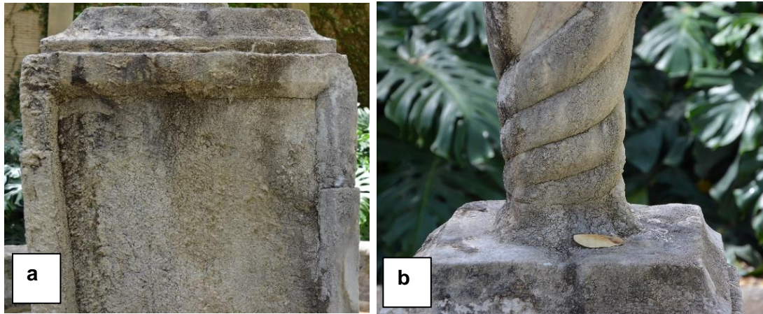
Figura 24. (a). Hinchamiento en la zona inferior del material, (b). Presencia de ampollas en la totalidad de la superficie. (Calvo, 2019).
