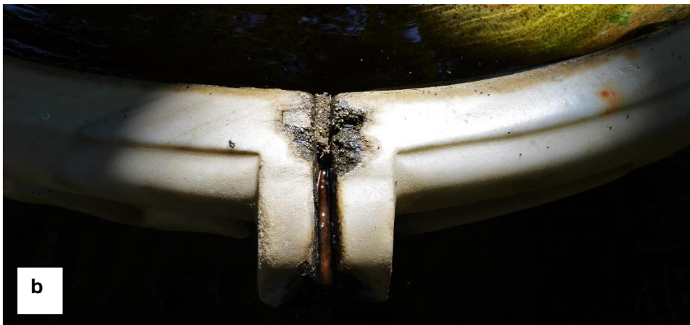
Figura 23. Disgregación del material en el depósito de la fuente. (Calvo, 2019).
