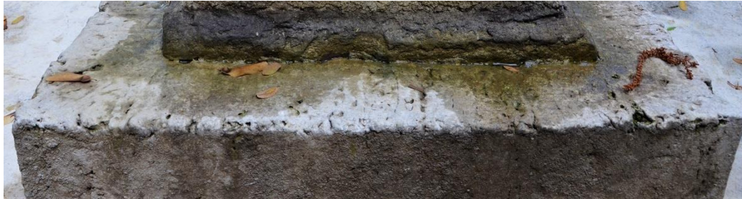
Figura 21. Excavación en el material pétreo. (Calvo, 2019).
