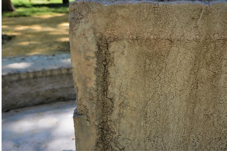
Figura 12. Costra en la superficie del material calcáreo. (Calvo, 2019).
