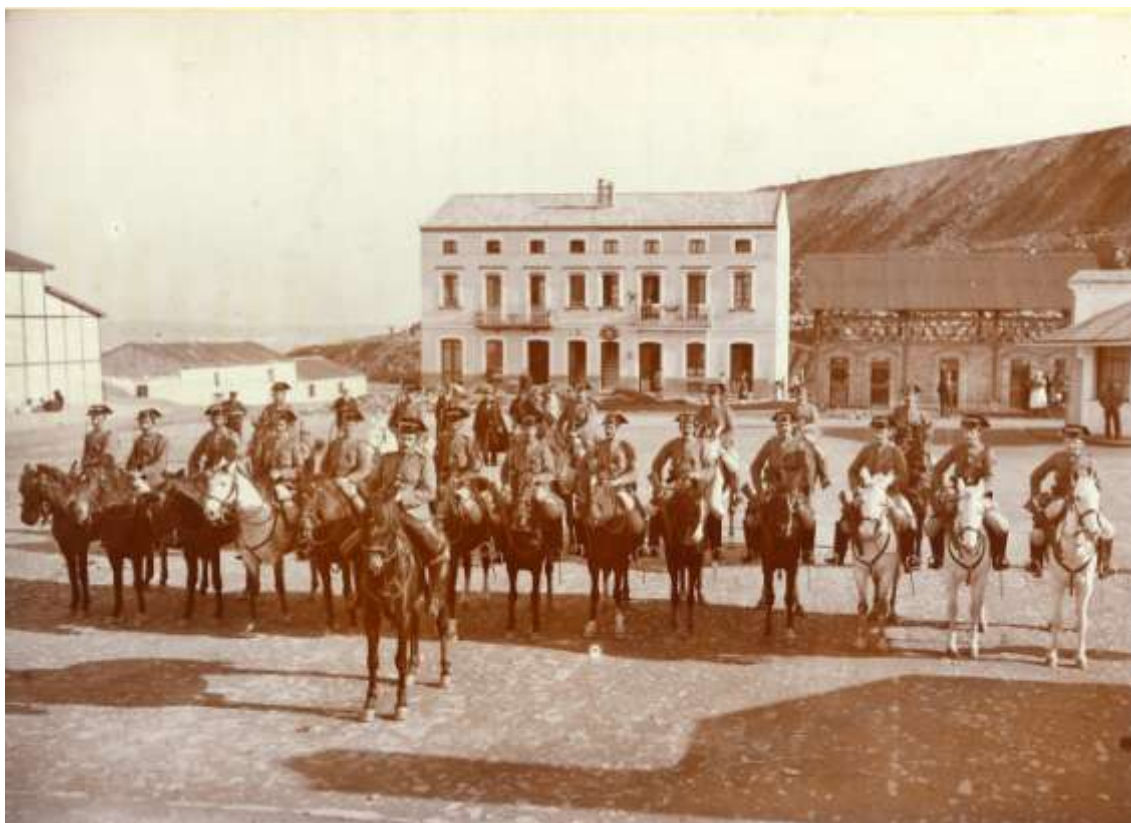
Figura 4. Sección Comandancia de Caballería de Valencia de Riotinto, 27-01-1914, antiguo poblado de Riotinto (Huelva), con casa cuartel al fondo. Fondo: Archivo Histórico Minero de Fundación Río Tinto, AH1-14.
