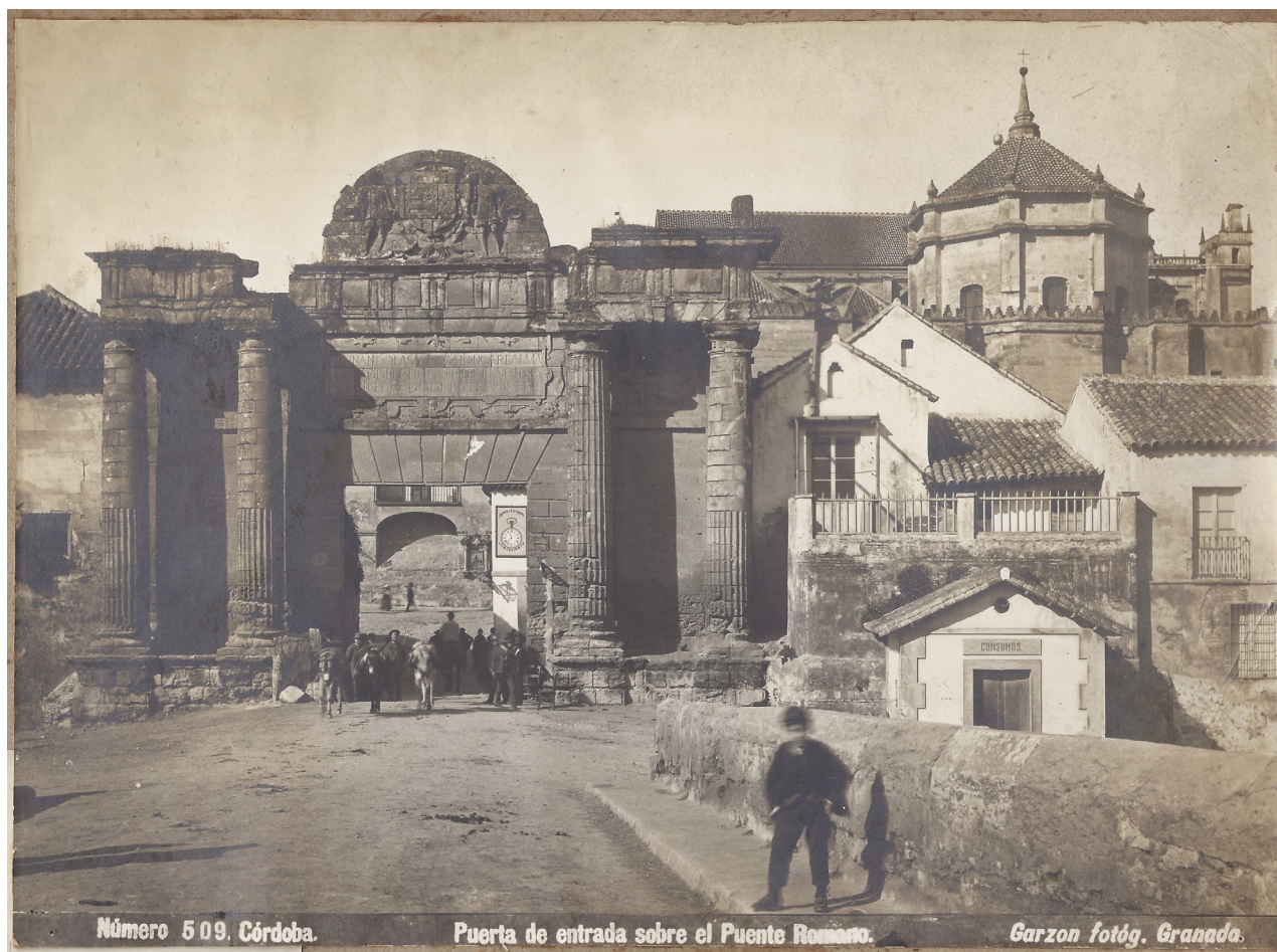
Figura 2. Puerta de entrada sobre el puente de Córdoba. Garzón, fot., 1896 (colección del autor).
