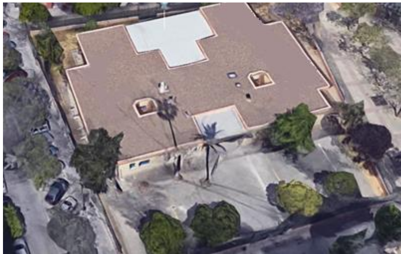
Figura 4. Edificio objeto. Fuente: Google Maps.
