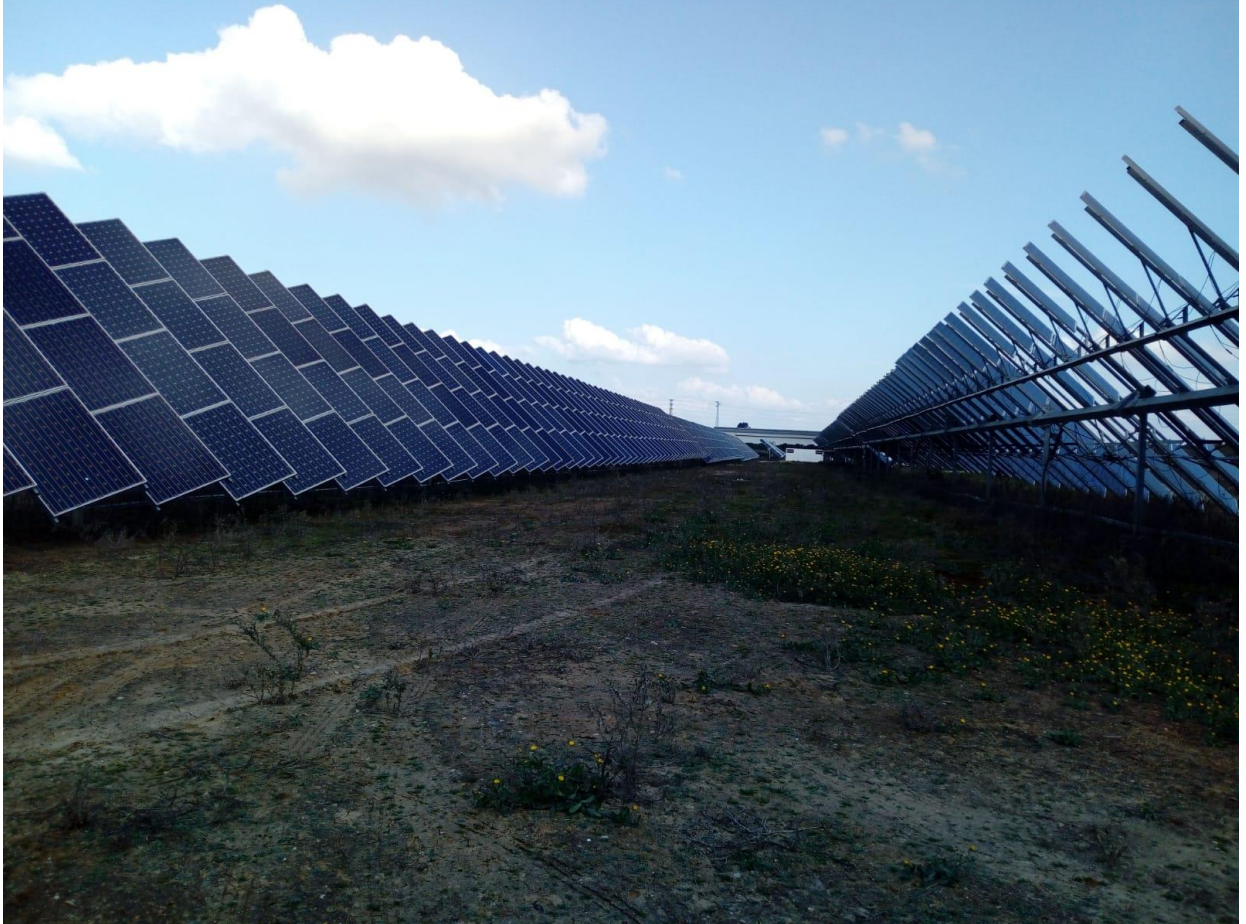
Figura 1-9. Estructura a 2 ejes EFV Aznalcázar
