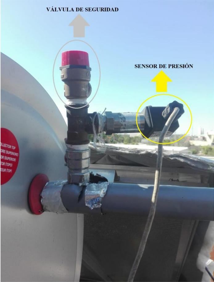
Figura 14. Detalle del sensor de presión y la válvula de seguridad.
