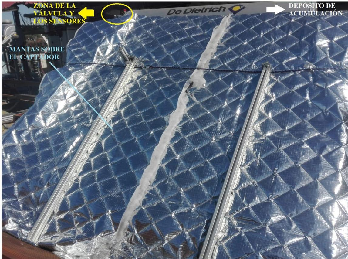
*Figura 17. Detalle de las mantas sobre el captador.*
