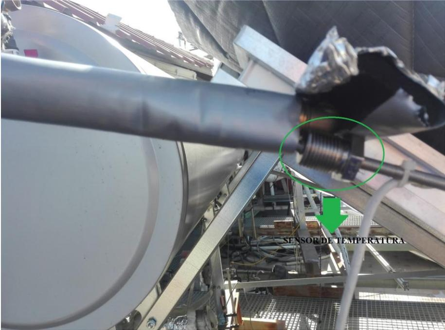
*Figura 15. Detalle del sensor de temperatura.*
