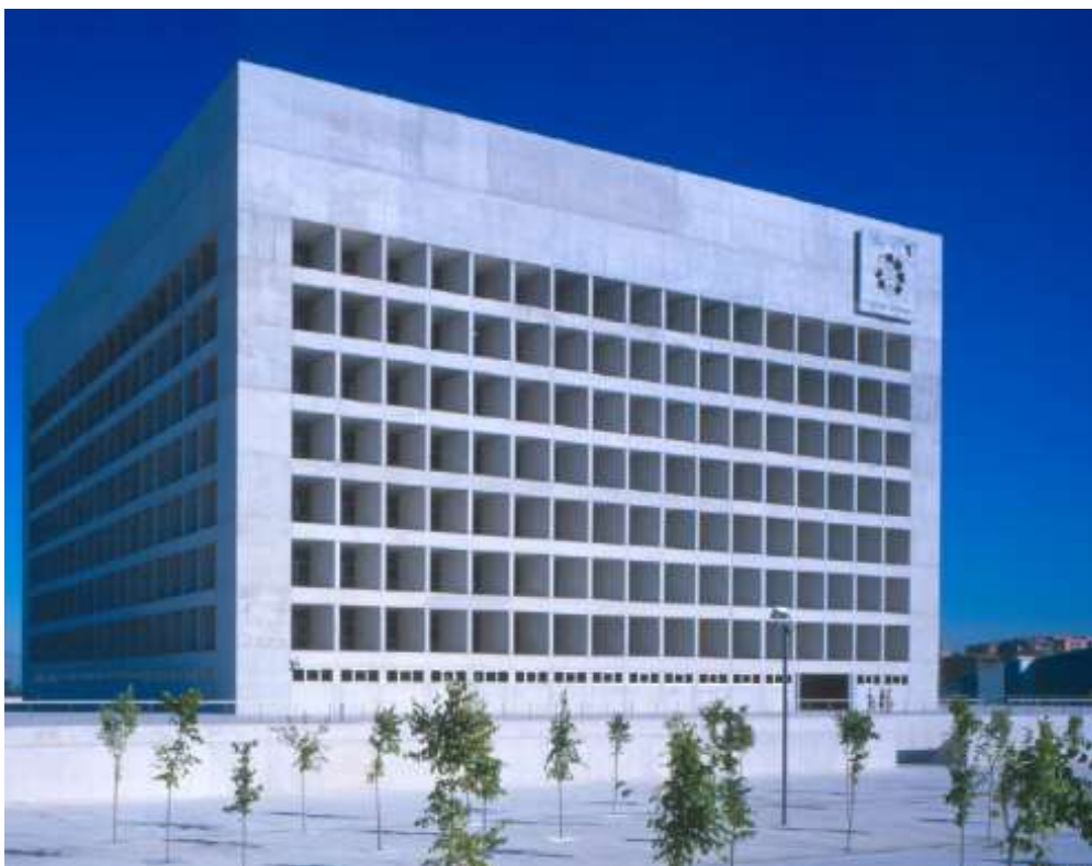
Figura 28: vista exterior de Caja Granada. (Arqu. Alberto Campo Baeza.)
