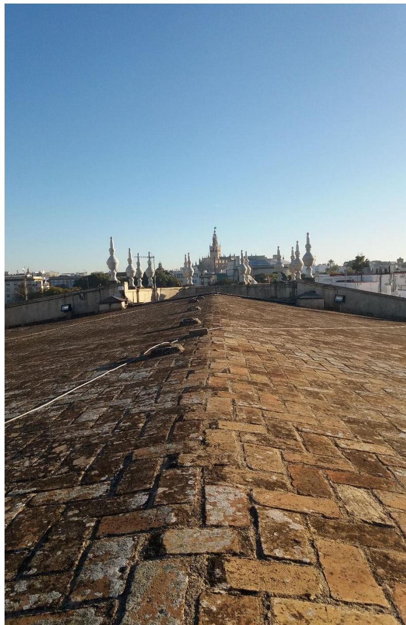
Figura 4-1 Vista desde la cubierta de la Iglesia de Santa Ana
