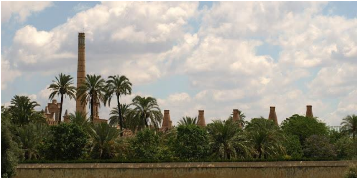
Fig. 41. Vista Chimeneas desde el Exterior
