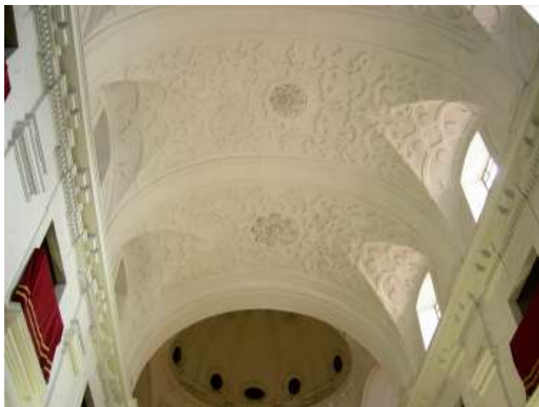
Fig. 3 Bóvedas de la nave . Iglesia del Señor San José, Sevilla. 1629.
