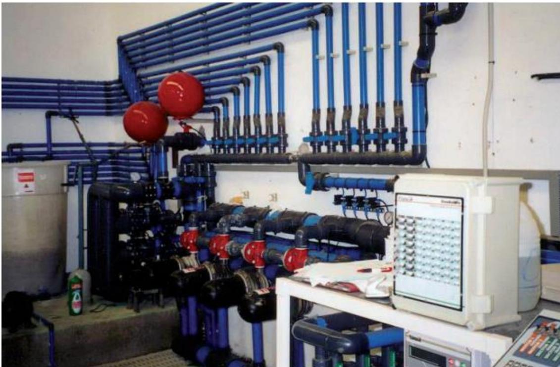
*Figura 8: Instalación de fertirrigación automatizada (Fuente: Valera et al., 2014)*
