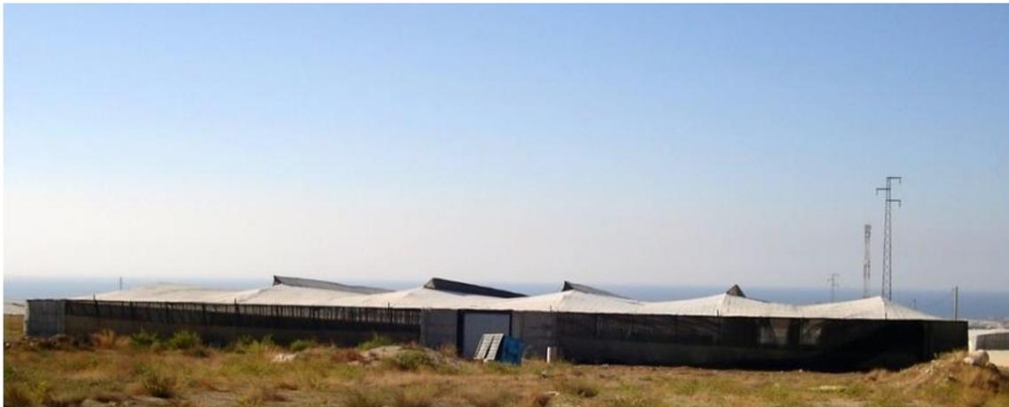
*Figura 17: Invernadero tipo "raspa y amagado". (Fuente: Valera, et al., 2014)*
