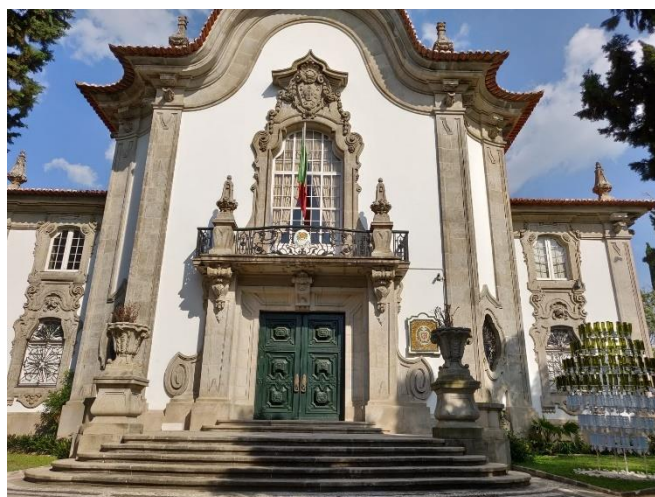
Figura 4.3. Fachada del pabellón
