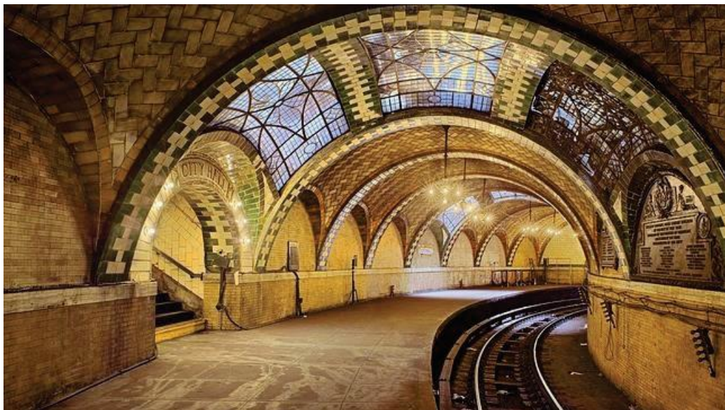
Figura 24: Estación de Metro de City Hall ("La catedral subterránea"). Guastavino. Nueva York (E.E.UU.)
