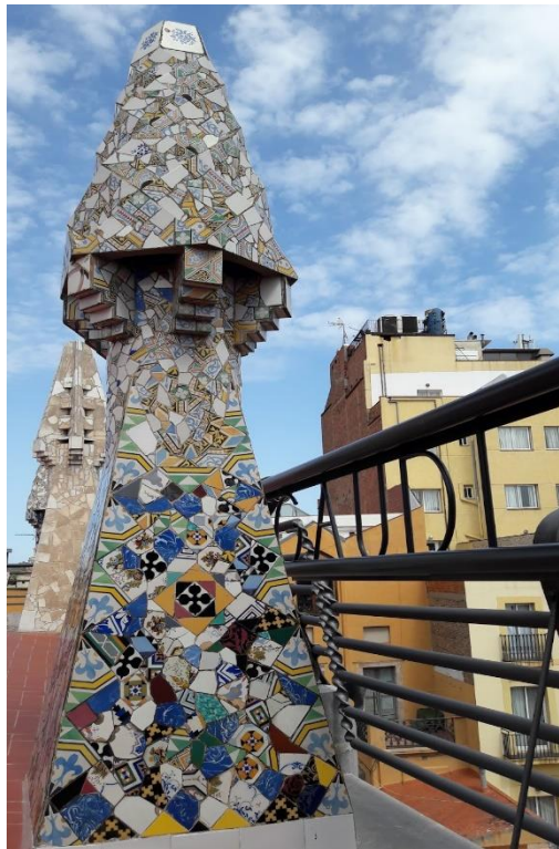
Figura 59: Chimenea número 13 de la cubierta del Palau Güell, Barcelona
