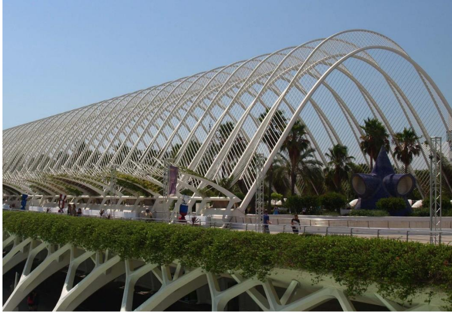
Figura 75: L'umbracle diseñado por el arquitecto Santiago Calatrava en la Ciudad de las Artes y de las Ciencias de Valencia. Su forma responde a un cilindro parabólico
