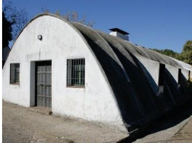
Figura 27: Viviendas ultrabaratas. 1953. R. de la Hoz y J.M. Paredes Villaviciosa de Córdoba (Córdoba).
