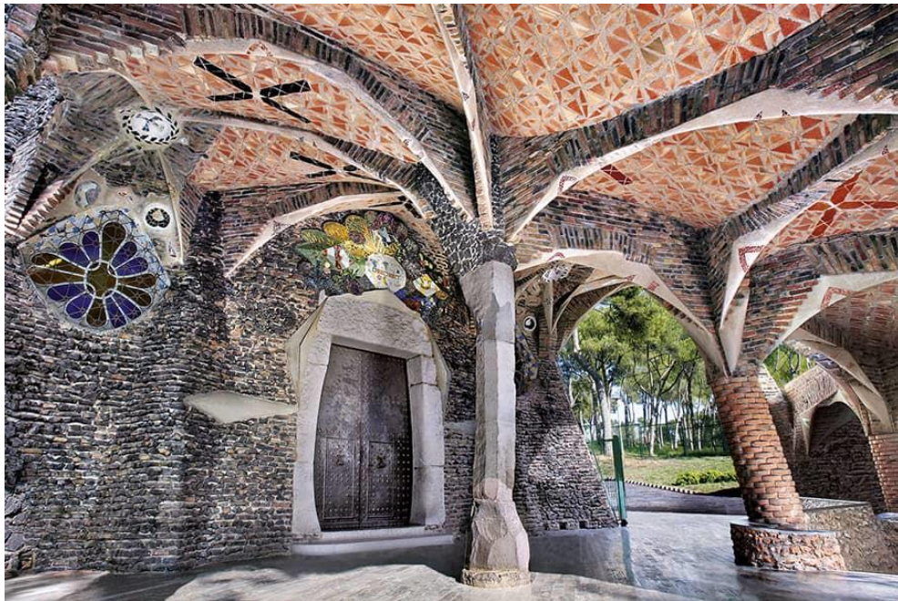
Figura 50: Bóvedas exteriores de la entrada de la Iglesia de la Colonia Güell
