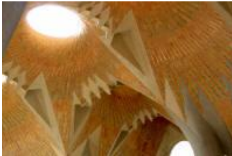
Figura 43: Techo de la nave central de la Sagrada Família. Barcelona
