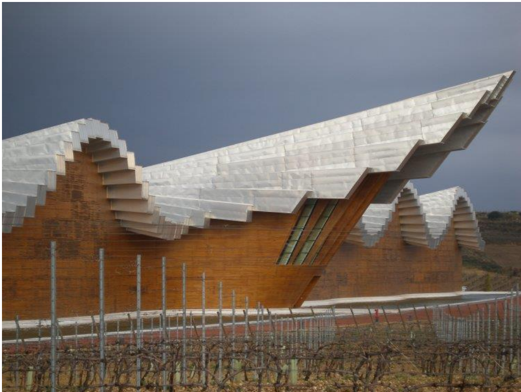
Figura 30: Bodegas Ysios de Santiago Calatrava. Laguardia (Álava) 2001
