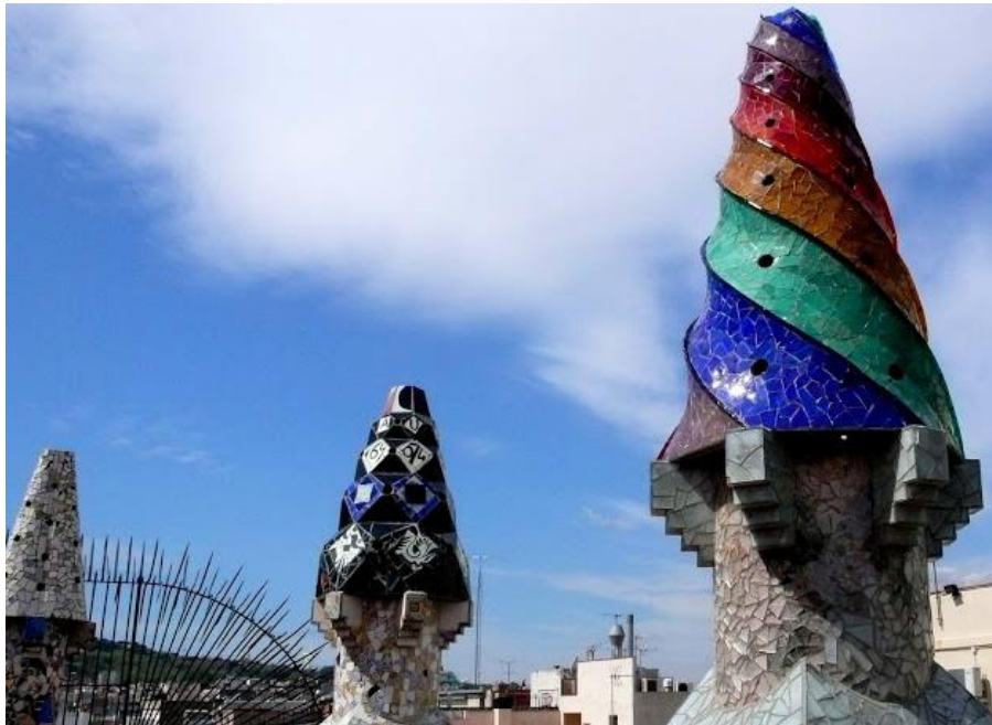
Figura 57: Chimeneas en la cubierta del Palau Güell, Barcelona
