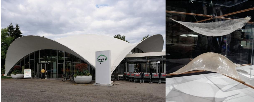
Figura 63: Izquierda: Garden Center Wyss de Heinz Isler.1961. Zuchwil (Suiza). Derecha: Modelo colgante de Isler antes y después de solidificarse.
