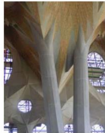
Figura 44: Nave principal de la Sagrada Familia. Utiliza hiperboloides en las aberturas de los ventanales y en otras aberturas en las bóvedas, también en el techo de la nave principal.
