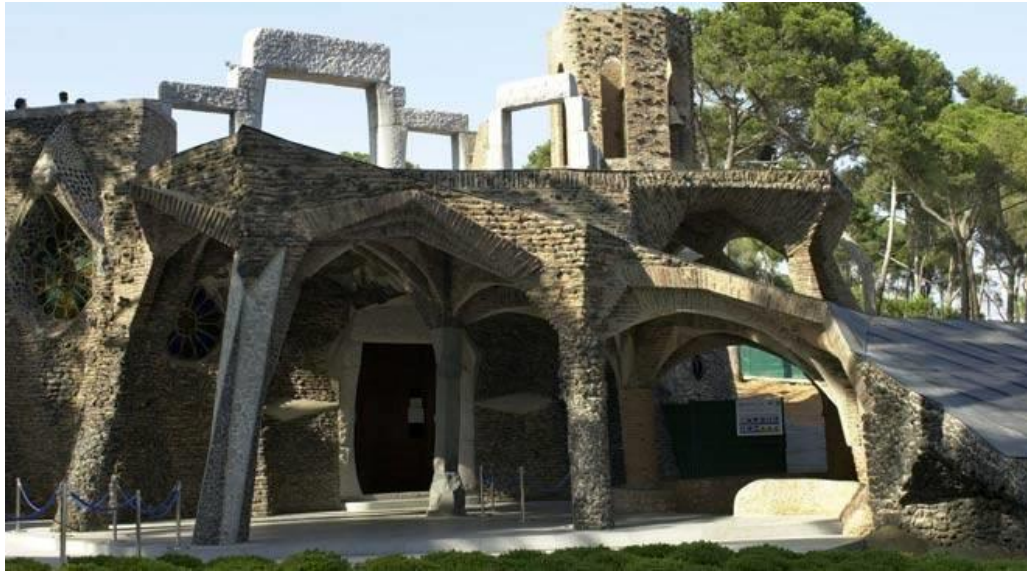
Figura 45: Fotografía de la Cripta de la Colonia Güell, Barcelona
