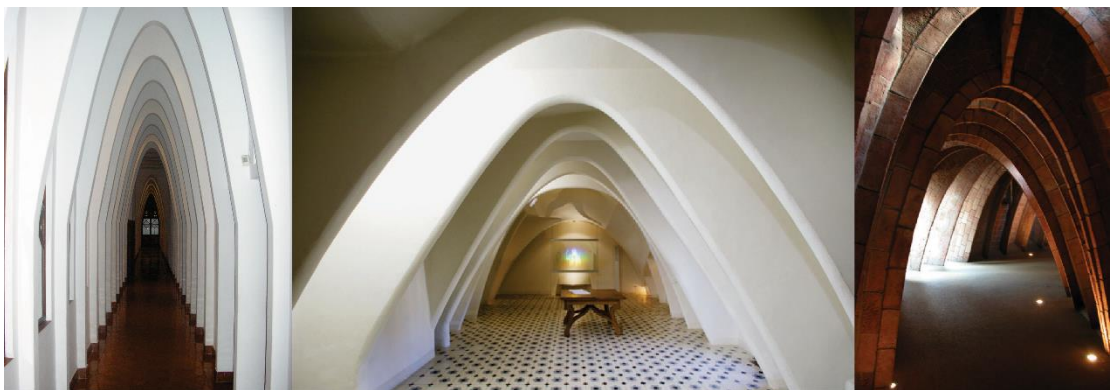
Figura 22: Arcos catenarios en el Convento de las Teresianas (izquierda), Casa Batlló (centro) y La Pedrera (derecha)
