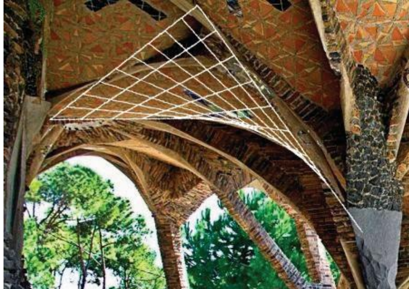
Figura 51: Forma de paraboloides hiperbólicos de la Cripta de la Colonia Güell. Gaudí. Barcelona (España)
