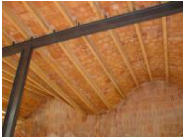
Figura 56: Detalle de la cubierta desde dentro de la Escuela Parroquial, Barcelona
