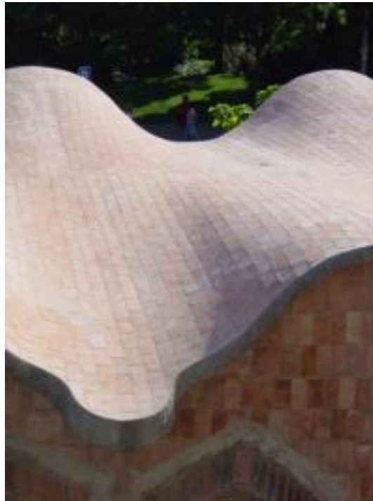
Figura 55: Detalle de la cubierta de la Escuela Parroquial vista desde arriba, Barcelona
