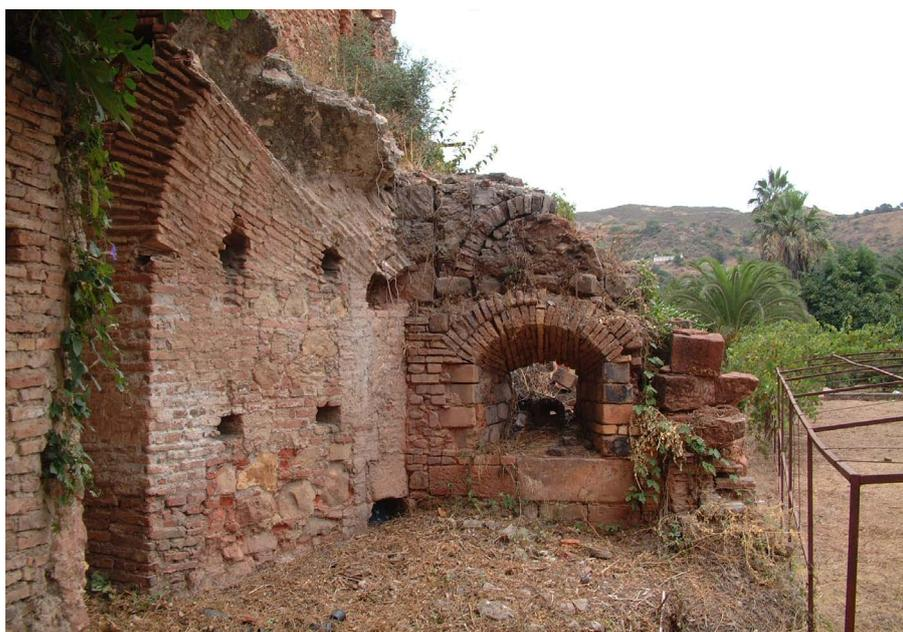
Restos de la bóveda occidental del alto horno Conde; se aprecia una de las boquillas de insuflado de aire en el crisol a través de barquines
