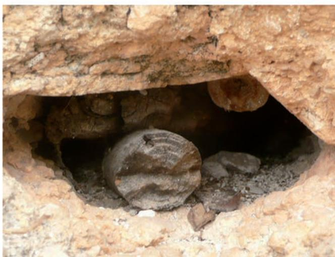
Figura 20. Media aguja rectangular dentro del tapial y conjunto de rollizos embebidos en la fábrica de la torre de Góntar, ubicadas en el punto donde el muro se escalona para cambiar de sección. Fuente: autor.
