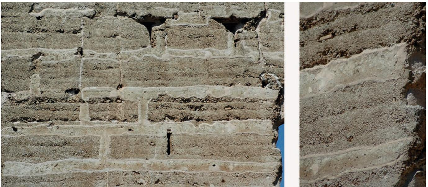
Figura 22. Calicostrados con falso despiece de sillares en la torre de Góntar. Detalle de las graffias y marcas recuperadas durante las labores de restauración realizadas en la torre en 2009. Fuente: autor.
