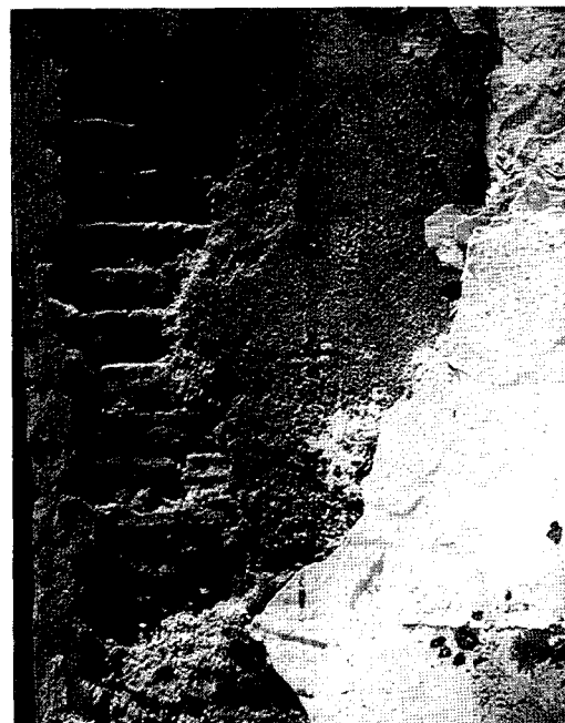
figura 4. Morteros de albero en muros y en revestimientos
