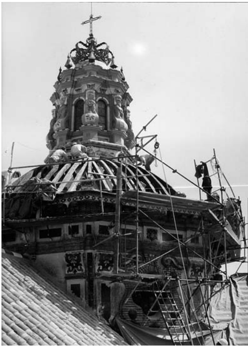
Figura 2 Vista de la cúpula abierta durante su restauración 1990-1991.
