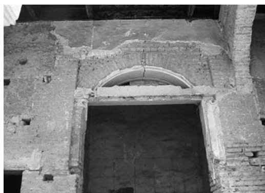
Figura 5 Detalle de arco de medio punto apuntado con alfiz, calle Segovias 1
