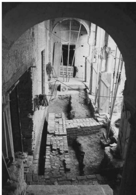
Figura 1 Resultado de vigilancia de movimientos de tierra en calle Segovias 1, nótese la cimentación que anulaba la casa del XV
