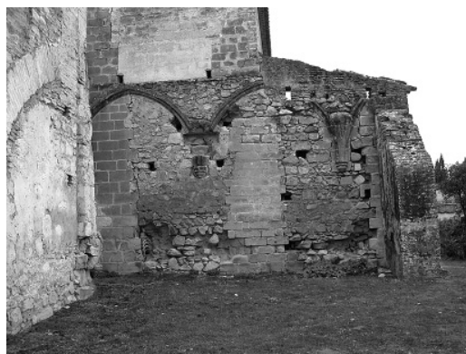
Figura 12 Fotografía del paramento oriental de la panda norte. Muro de las celdas (Autores 2006)
