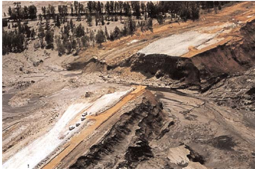
Foto 3.1. Rotura de la balsa de decantación de la mina de los Frailes (Aznalcóllar, Sevilla), en abril de 1998. Foto: archivo de la Consejería de Medio Ambiente.
