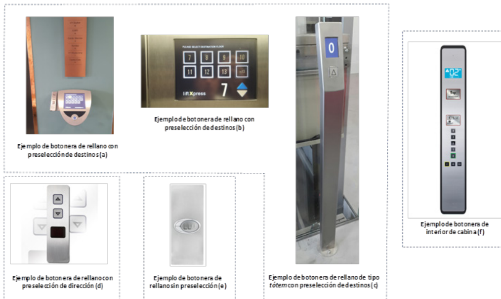
Figura 4 Imágenes de diferentes botoneras para llamadas de ascensores.
