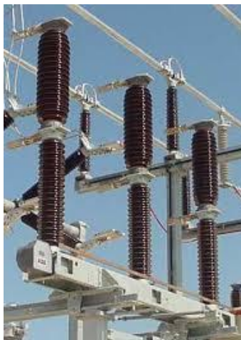
Figura 10. Interruptor automático.
