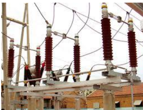
Figura 11. Seccionadores.
