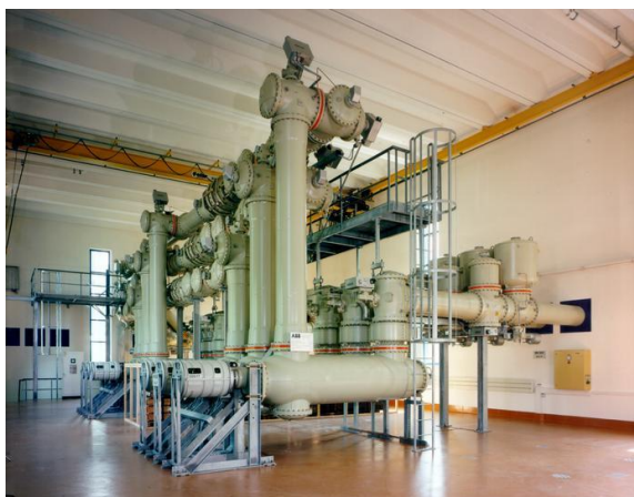
Figura 6. Subestación blindada.
