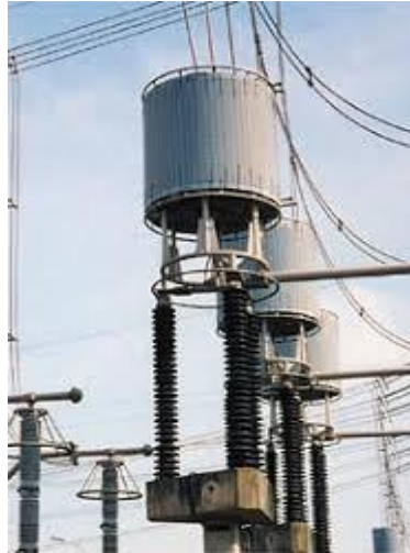
Figura 16. Trampas de onda o bobinas de bloqueo.
