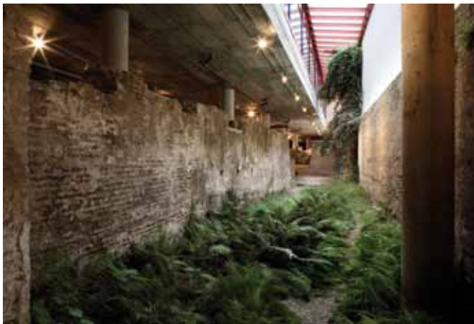
Barbacana. Estado previo
