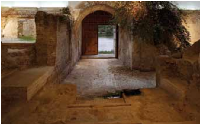
Puerta de Barcas. Estado previo
