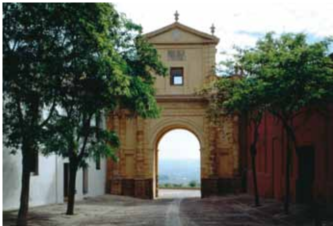
Puerta de Córdoba de Carmona. Fachada occidental. Foto: Fernando Alda
