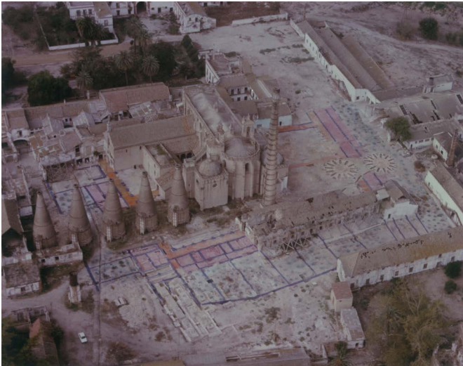
Imagen aérea de la zona del claustro de monjes después de las demoliciones donde se identifica la traza del claustro sobre los restos arqueológicos | foto Informe sobre el estado de las obras de conservación del conjunto monumental de la Cartuja de Sevilla, Centro de Documentación del Centro Andaluz de Arte Contemporáneo
