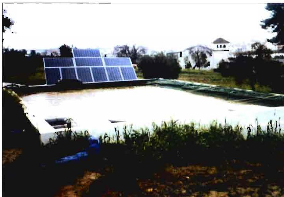
Diciembre de 2000 Balsa llena. Al fondo paneles solares sobre remolque. Dentro de la balsa en primer plano, descarga de agua y tapas de los decantadores
