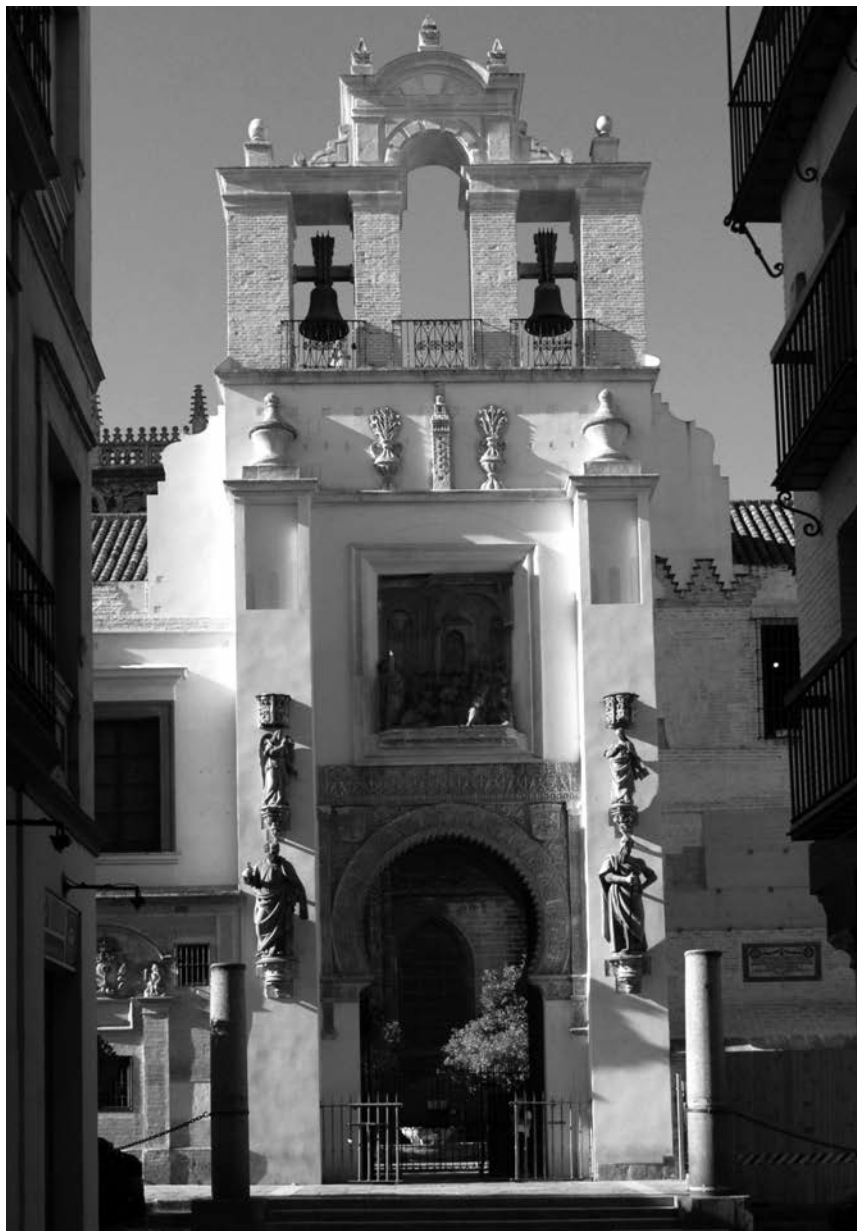
Figura 3. La portada norte de la puerta del Perdón desde la calle Hernando Colón, eje norte-sur de la Alcaicería, tras la restauración de 2014, apreciándose, a la derecha, el muro de tapial y los tres merlones de grada recuperados durante las obras (Foto del autor).
