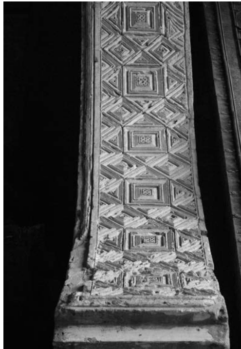
Figura 8. Decoración del arco “121Js”; en la parte izquierda de la imagen, que corresponde al lado sur, se observa prácticamente completo el conjunto de molduras que enmarcan el panel decorativo de cuadrados, mientras en el lado izquierdo ha desaparecido casi por completo (Foto del autor).
