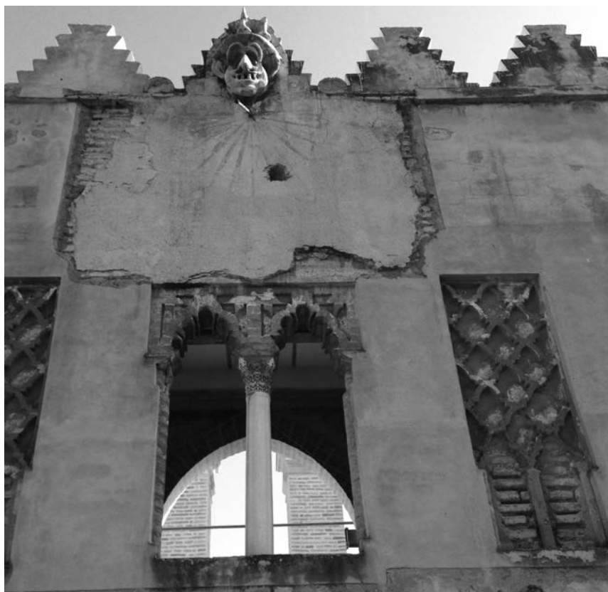
Figura 15. Parte central de la fachada sur del mirador antes de las obras de restauración de 2014; destaca la bífora central, con capitel califal; los arcos de esta ventana, de ladrillo visto y rosca bilobulada, con su alfiz de dos picos; a izquierda y derecha aparecen los paños decorativos (Foto del autor).
