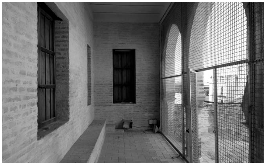
Figura 16. El espacio del torreón tras las obras terminadas en 2014; salvo las ventanas de madera y la malla, todo está como lo terminó Hernández Giménez; destacaremos los dinteles originales, con sus gorroneas, y el rejel bajo el hueco de la ventana lateral (Foto del autor).
