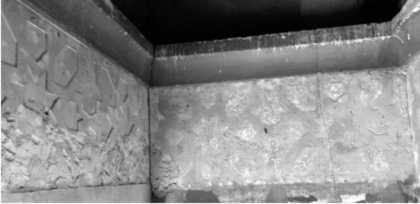
Figura 7. Friso con decoración de lazo, ubicado sobre el espacio de las mueven las hojas de la puerta; en el lado izquierdo se observa que casi la mitad inferior está picada intencionadamente y que es nueva la banda lisa que cubre el dintel, señales de que éste fue reparado en algún momento (Foto del autor).
