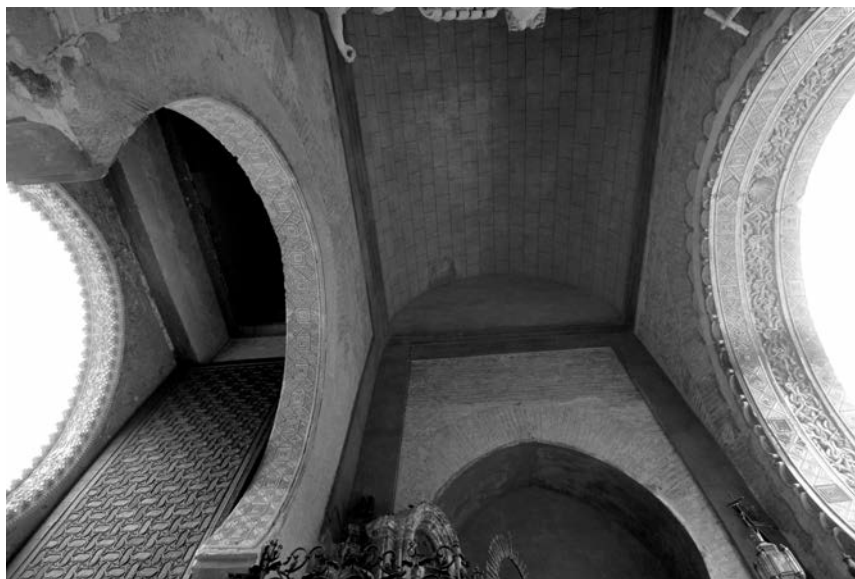
Figura 12. Partes altas del espacio del zaguán desde la portada de la Caridad; de izquierda a derecha: arco “I21Jn”, hoja de levante, friso de lazo, arco “I21Js”, la reja y ático del retablo del Ecce Homo, arco “20I21”, bóveda de cañón, farol de san Millán y finalmente el arco “I20J” (Foto del autor).
