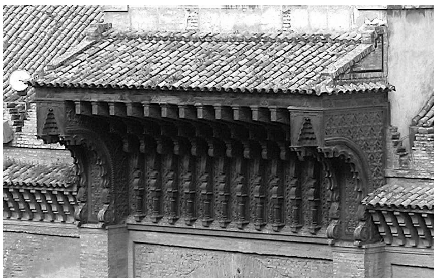
Figura 14. Parte superior de lo que queda de la arquivolta lobulada del arco “I20J”, en su versión primigenia, recuadrado por su alfiz; sobre ellos vemos el tejazoz diseñado y construido por Hernández Giménez; sobre las últimas tejas del tejazoz se inicia el paramento del mirador o torreón (Foto del autor).
