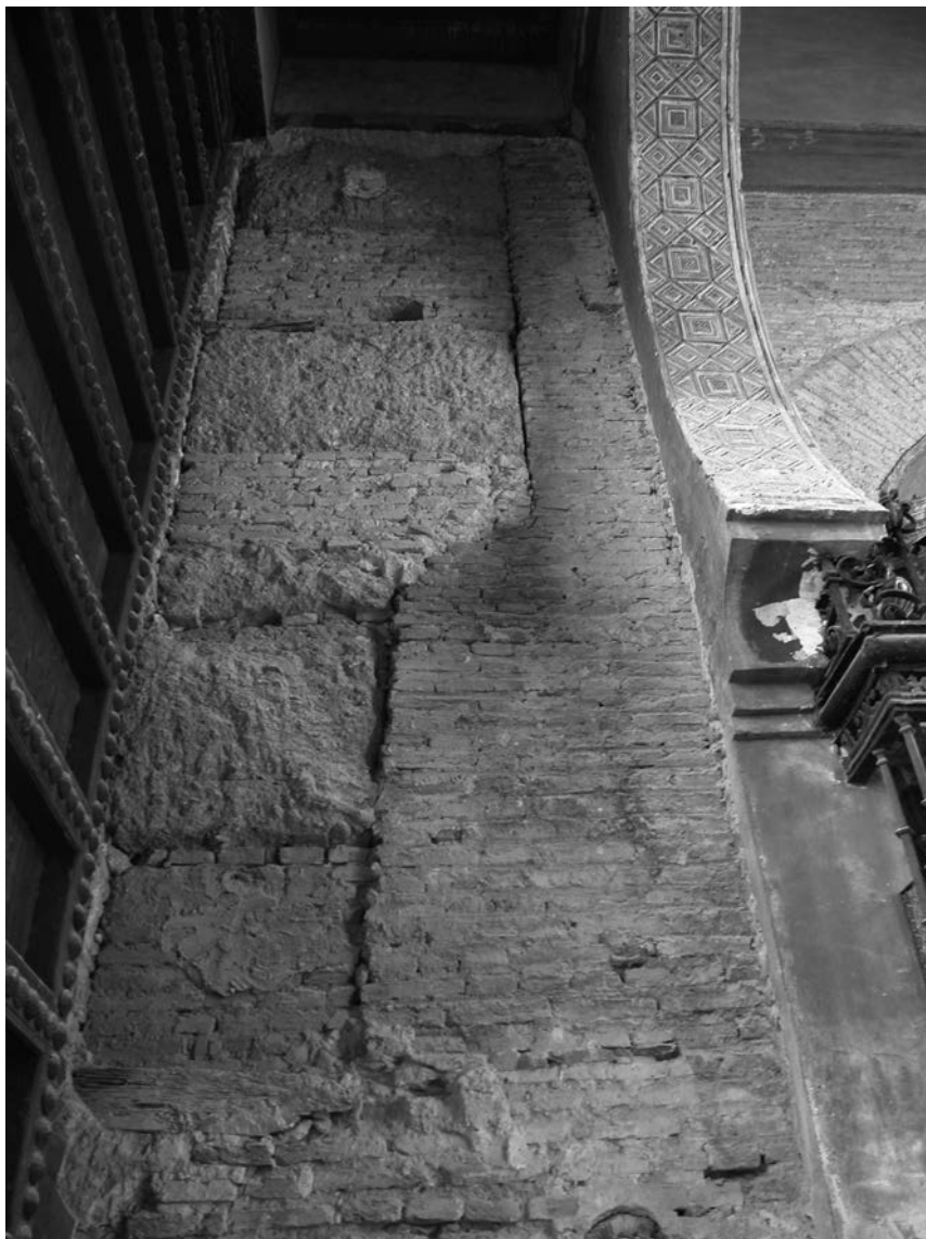
Figura 19. Desde los años setenta del XX, así se ve la mocheta del lado de levante de la puerta, apariencia que le quedó al muro de tapial una vez que se eliminó casi por completo el ladrillo que lo encofraba y las jambas de un arco menor (Foto del autor).
