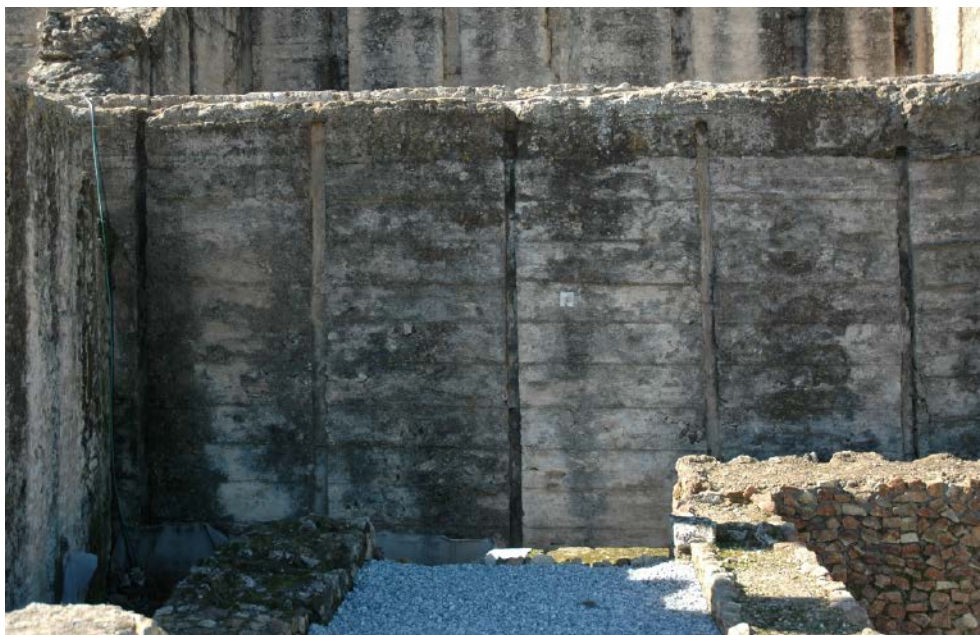
Figura 7. Detalle de las improntas de las tablas horizontales y los costeros verticales de madera sobre la fábrica.
