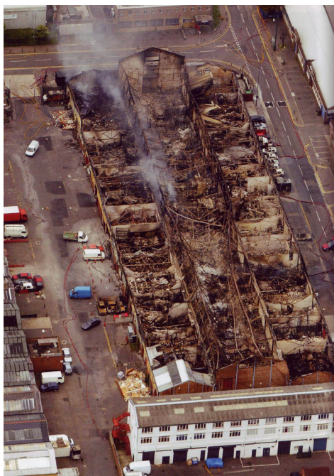
Figura 2. Incendio en los almacenes de Momart, en Leyton, 2000. © Rex Features.
