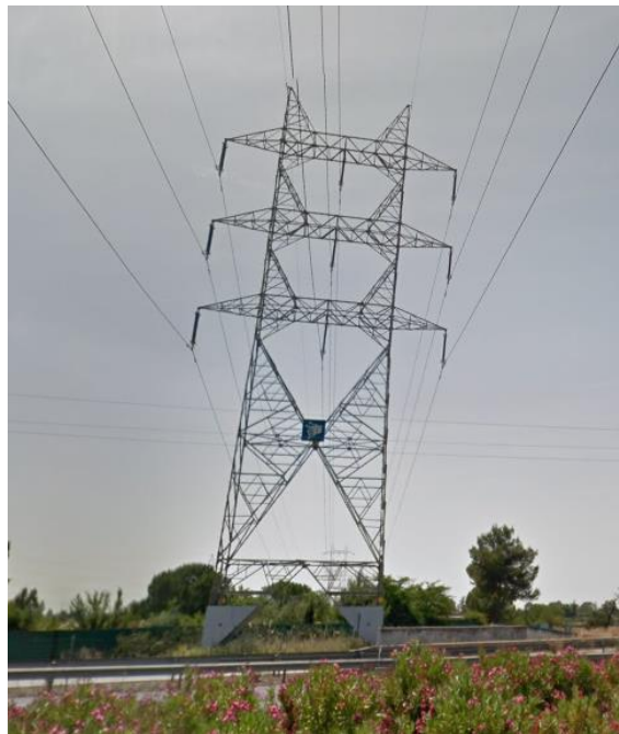
Figura 4-2. Apoyo de 220 kV con tres vigas
