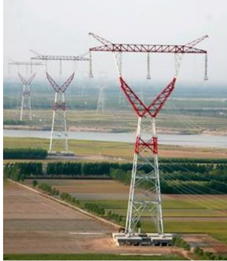
Figura 4-1. Apoyo tipo Delta (cara de gato)
