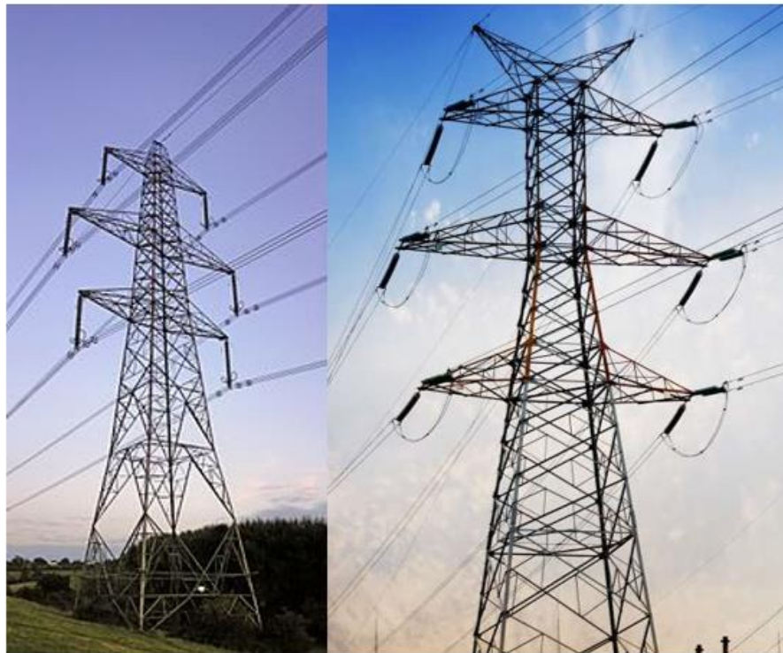
Figura 2-1. Apoyo de suspensión(izquierda) y amarre (derecha)
