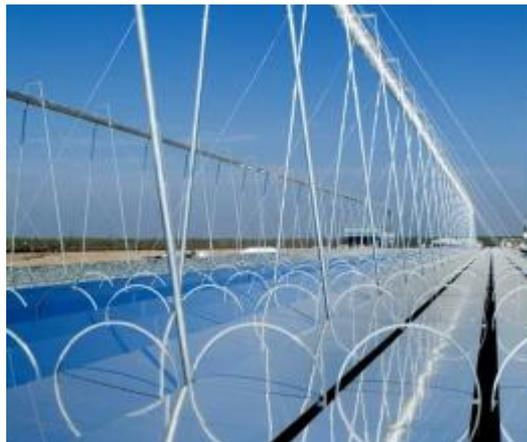
Figura 7. Concentrador lineal de fresnel. [3]
