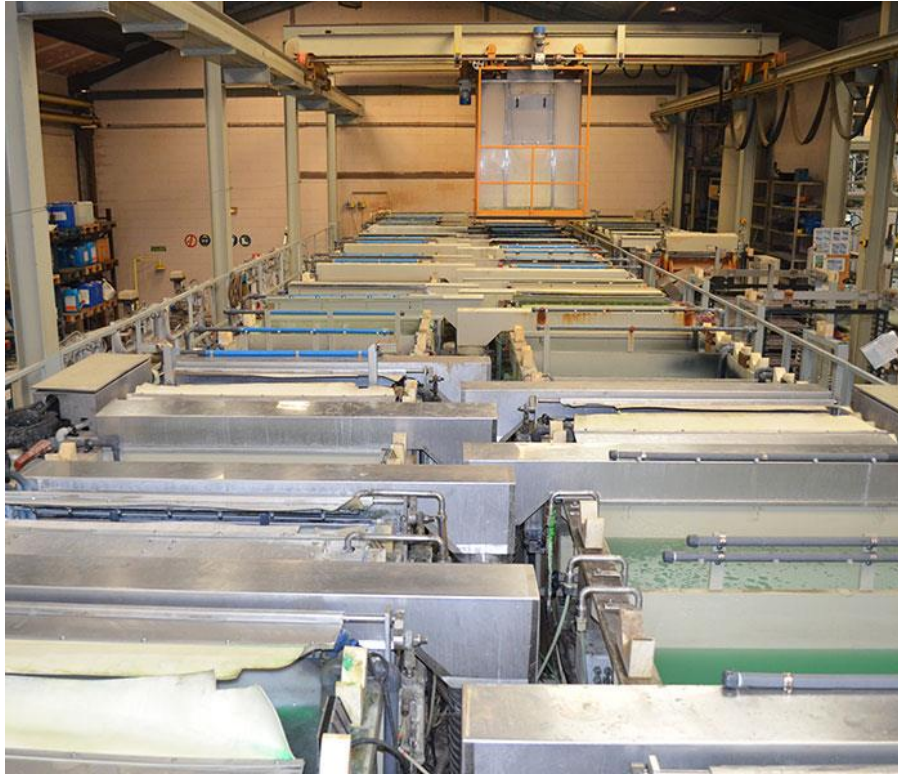
Figura 6. Cadena de baños de proceso químico
