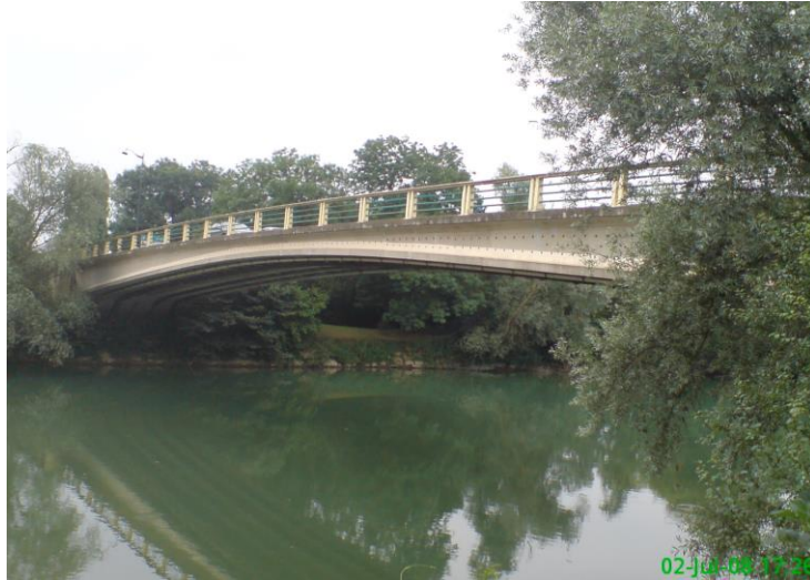
Figura 1.5. “Pont de la libération/Esbly Bridge”. Puente de Esbly por Eugene Freyssinet (1949).
