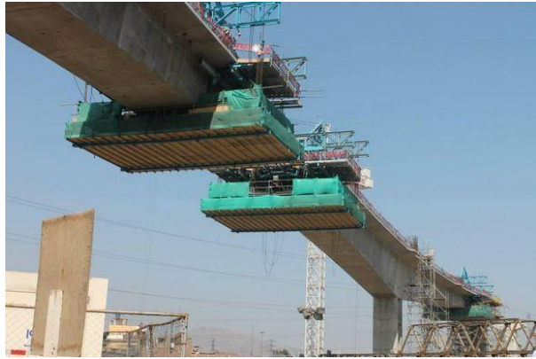
Figura 1.22 Encofrado deslizante para la realización de dovelas in situ. Método constructivo: voladizos sucesivos
