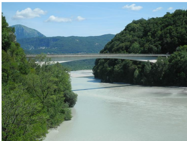
Figura 1.4 “Ponte di Pinzano”. Puente de Pinzano (Pinzano al Tagliamento, Italia) por S. Zorzi (1968).
