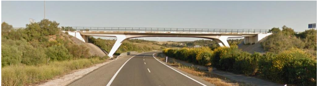
Figura 4.1 Puente pórtico tipo Strut Frame de la Autovía A-381 en Medina Sidonia (Cádiz, Andalucía, España)
