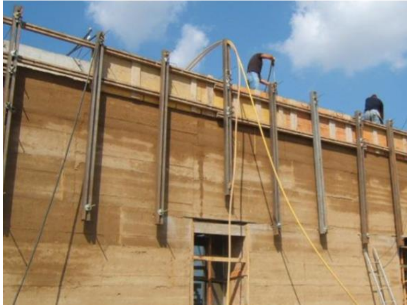
Ilustración 3: Construcción con tapia en la actualidad, [1]
