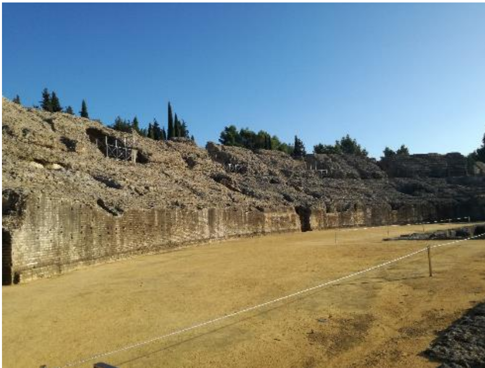
Figura 5.4. Vista del graderío y el podio desde la arena del Anfiteatro.
